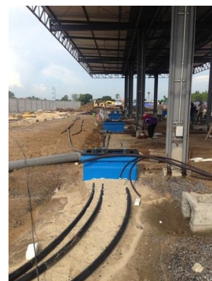
Chantier de station
